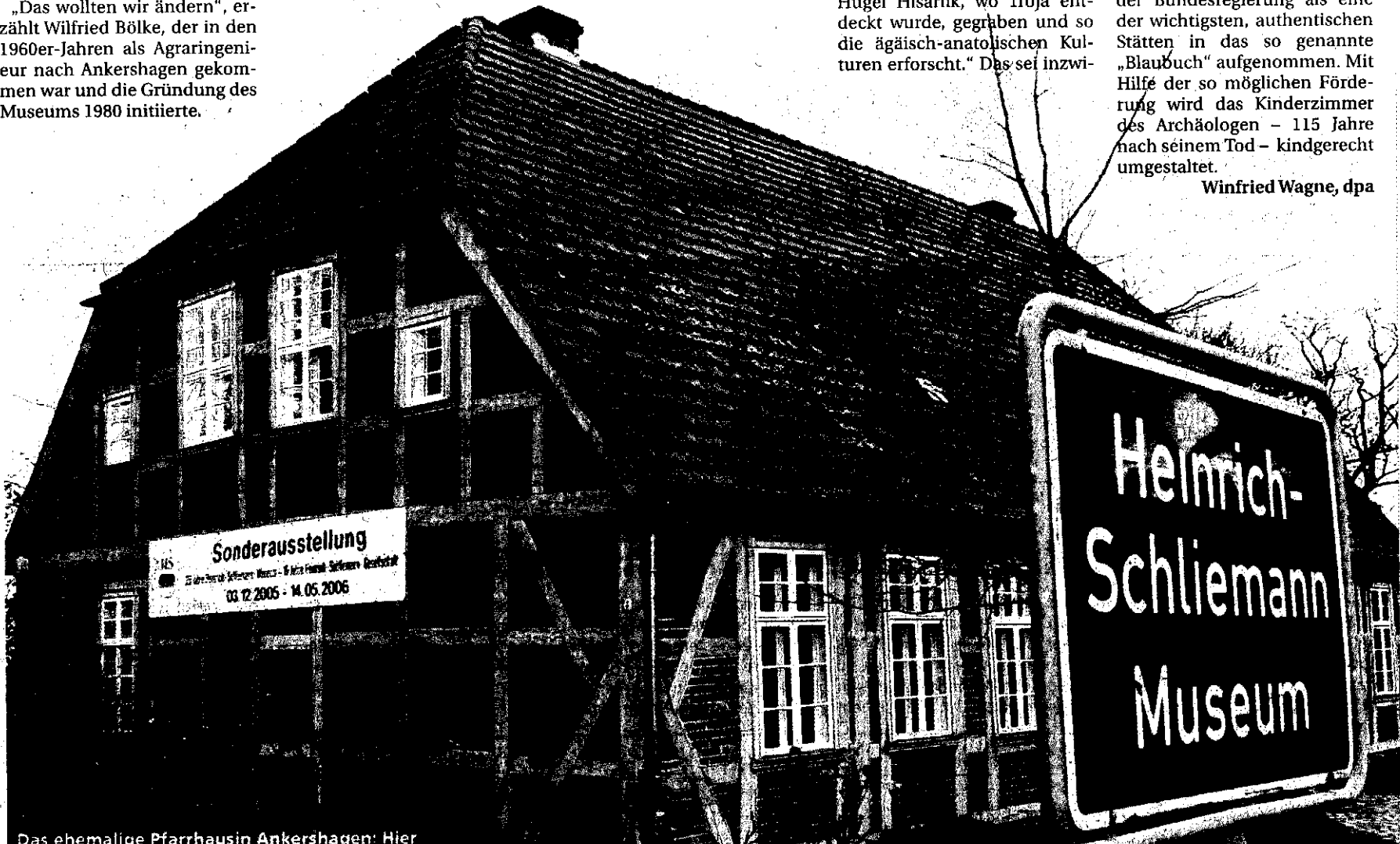
Das ehemalige Pfarrhaus in Ankershagen: Hier
